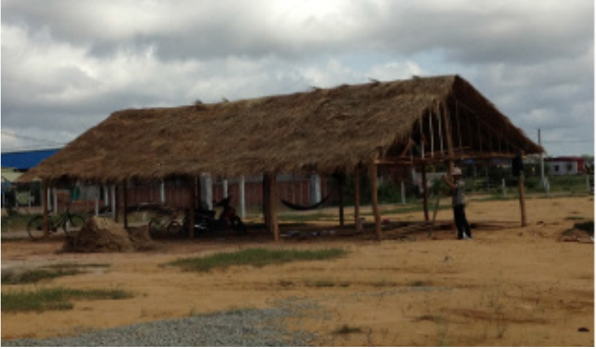
임시 예배처소 공사 모습입니다.
